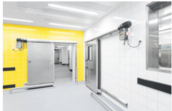
Die SI-Schiebetür ist in jeder Hinsicht eine saubere Lösung! Funktion, Design und Konstruktion sind perfekt aufeinander abgestimmt. Ein gerolltes Edelstahlprofilrohr schützt die Lauf- und Antriebselemente vor Verschmutzung. Diese Bauweise erfüllt die höchsten Ansprüche an Hygiene und Reinigung und besticht außerdem durch eine klare und edle Optik.
